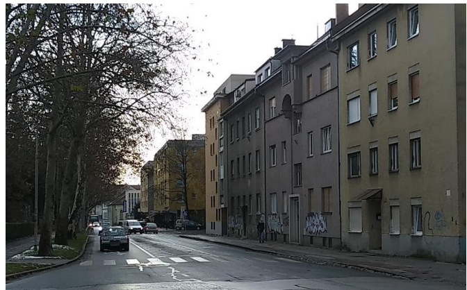
*Gosposvetska Fotografija s križišča z Vrbansko cesto
