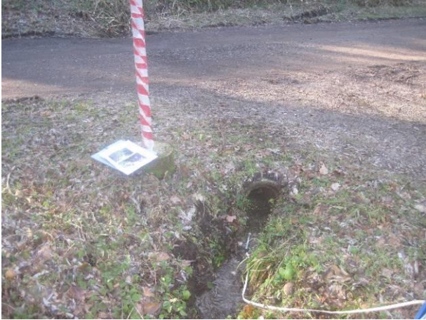
Fotografija 1: Izvir 3 (cevni prepust pod cesto)
