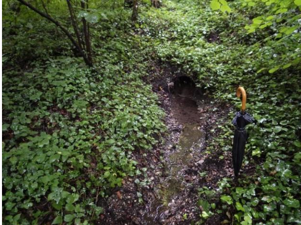
Fotografija 6: Izvir 5 (cevni prepust pod cesto)
