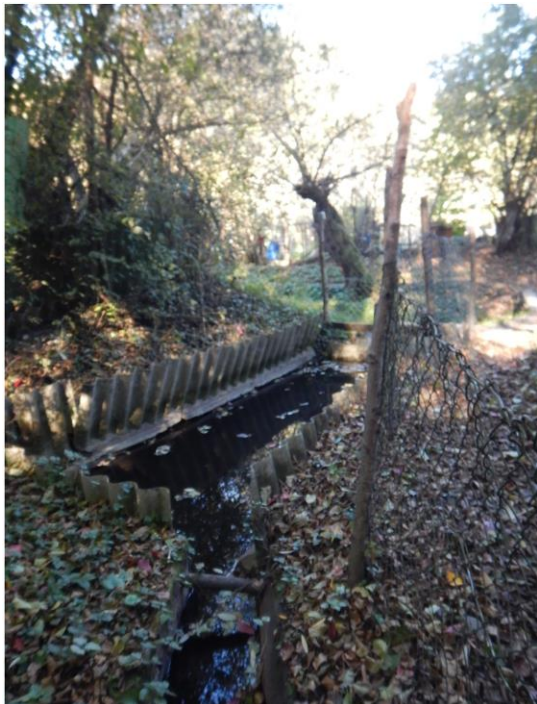
Fotografija 3: Večja zaježitev izvira 3 za potrebe zalivanja vrtičkov tik pred izlivom v Stražunski potok.
