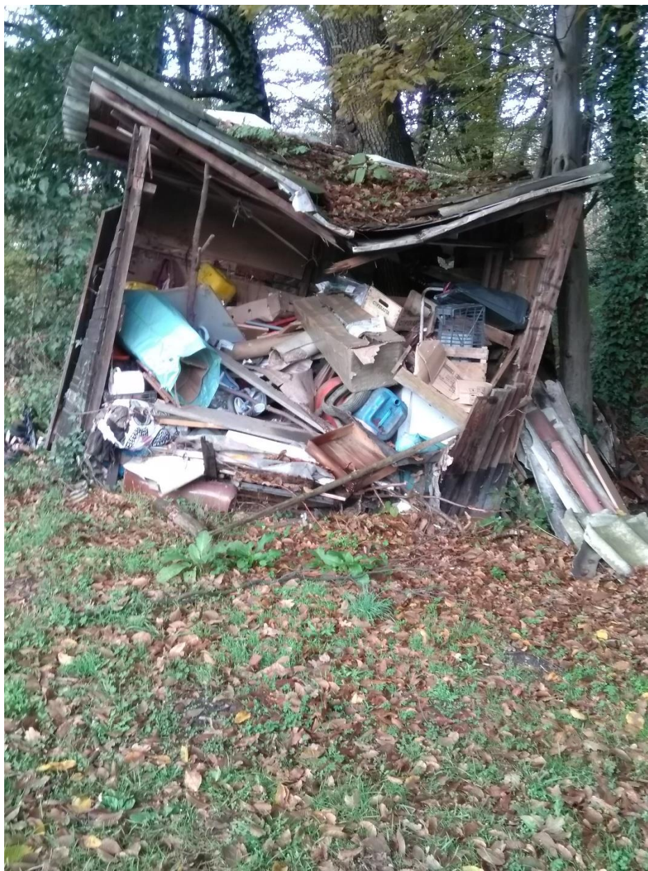
Slika 54: Nelegalno odlagališče odpadkov v Stražunu, pred čiščenjem v 2021 (Vir: SSVO)
