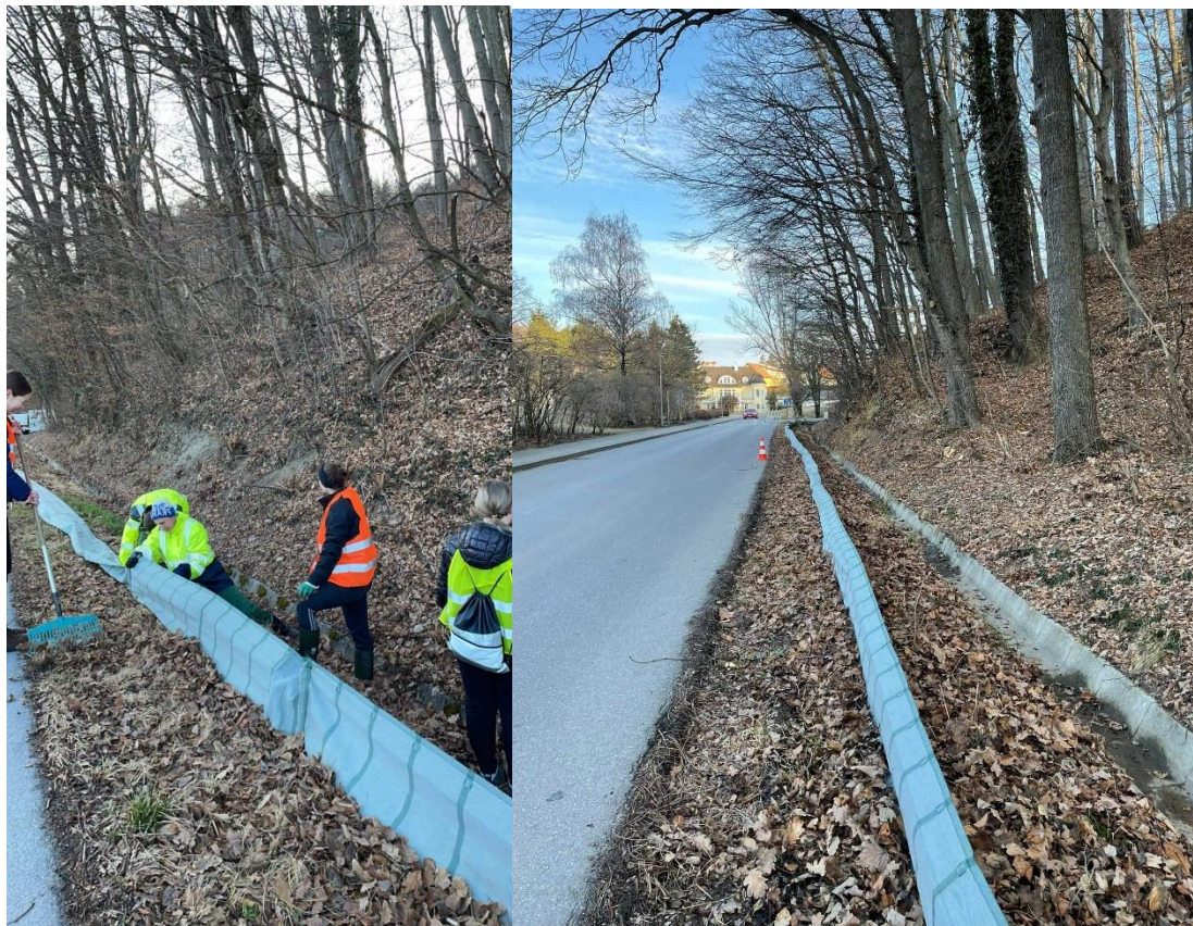
Sliki 1 in 2: Postavljanje ograje (Avtor: Nuša Šoštar Pirš).
