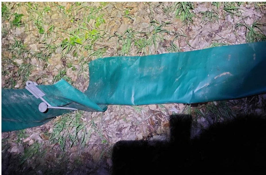
Slika 4. Razpadla ograja zaradi problematične podlage in posledične neustrezne namestitve klinov (Slika: Tina Mihelič)
