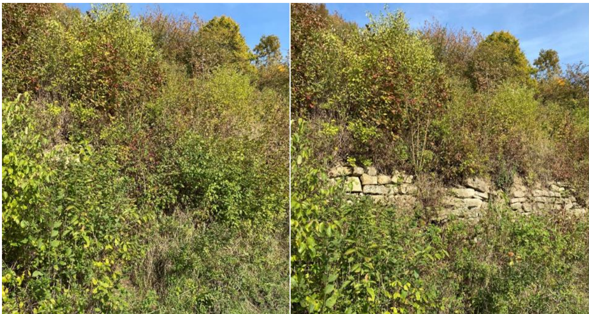
Slika 5. Suhozidovi pred in po renaturaciji in odstranitvi odvečne vegetacije (foto: Manca Marija Strmšnik)
