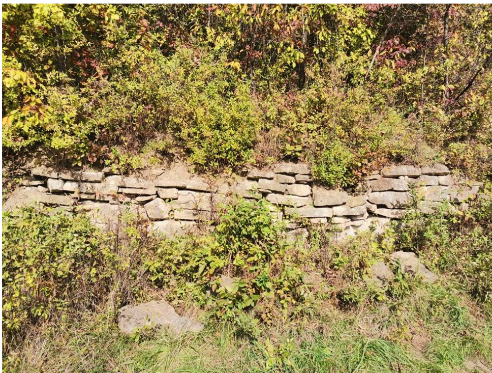
Slika 7. Suhozid po renaturaciji in odstranitvi odvečne vegetacije (foto: Sarah Ines Rakuš)
