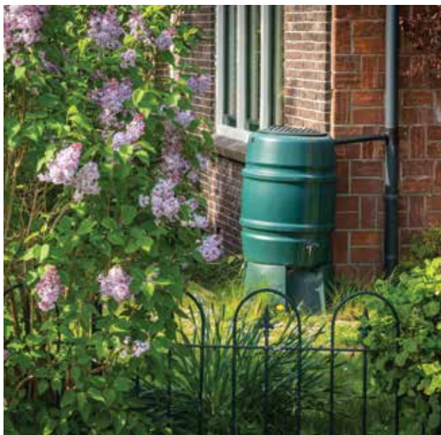
SLIKA 1: Sod ob hiši povežemo z žlebom za zbiranje deževnice.
