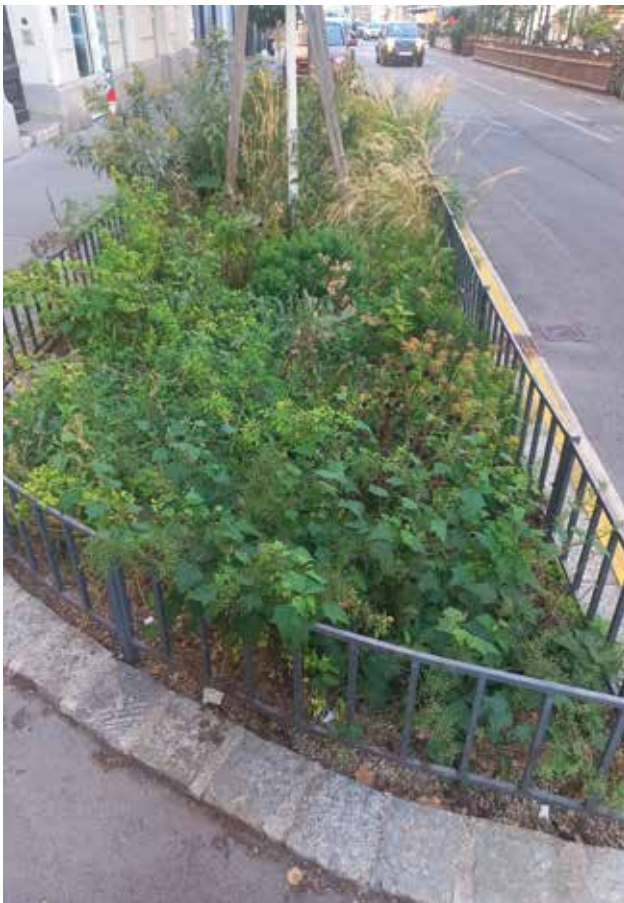
SLIKA 2: Padavinsko vodo iz površja usmerimo v kotanjo deževnega vrta.
