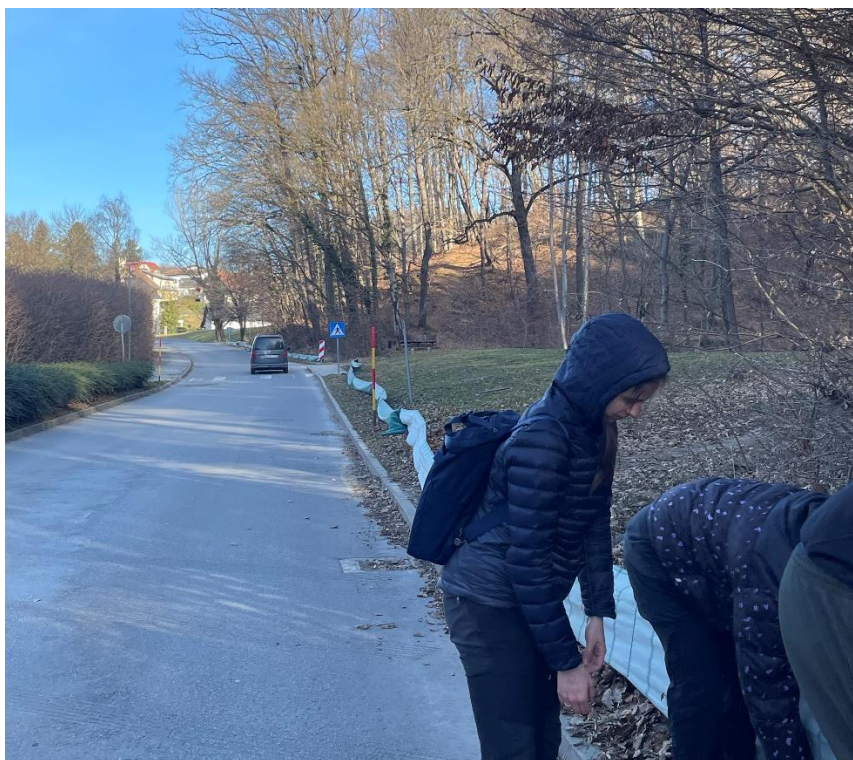
Slika 1. Postavljanje ograje (Slika: Ema Šušterič)
